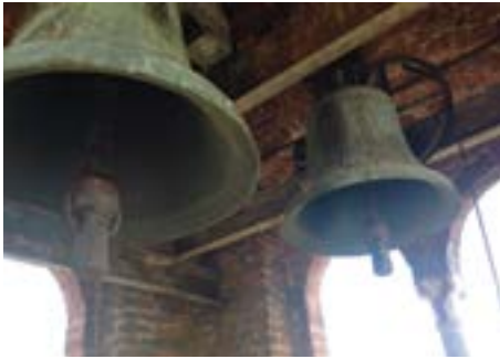
Campane della cella campanaria.
