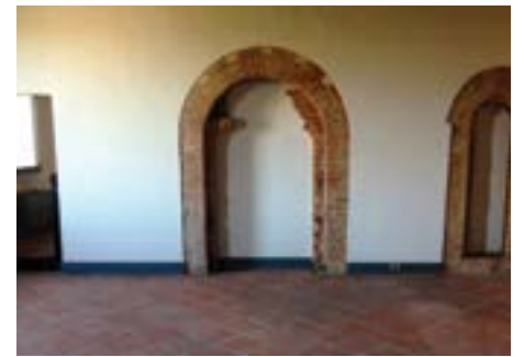
Al primo piano dell'edificio residenziale originario: resti della bifora e della monofora che si affacciavano sulla parete esterna ovest, nel locale adibito al dormitorio dei frati. E' probabilmente il reperto architettonico più antico del complesso abbaziale (1220, 1230 circa).
