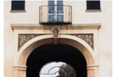
Decorazione dell'arco di accesso al vecchio cortile industriale (trasformato in deposito per carrozze) e sovrastante balconcino settecentesco: forse si trattava dell'alloggio del rappresentante del Collegio Elvetico, oppure dell'abitazione del fittabile.
