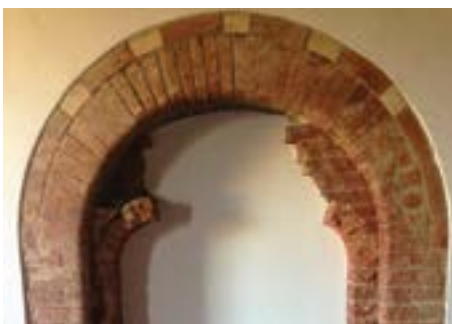
Particolare della bifora.
